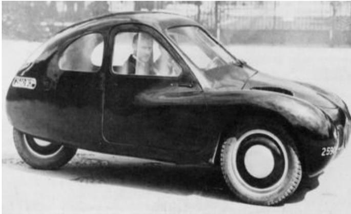
Nicht wegen des Wegfallens des Differentials verwendete man nur ein hinteres Rad (der Wagen wird vorne angetrieben!), sondern wegen der aerodynamischen Tropfenform, auf die Bertoni Wert legte. Die Karosserie wurde selbsttragend aus Aluminium gefertigt und brachte gerade mal 78 Kilo auf die Waage. Das Gesamtgewicht betrug 386 Kilo.
