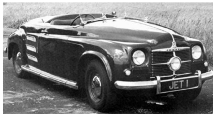
Im März 1950 präsentierte Rover den ersten Gasturbinen-Wagen, den T1. Als Basis diente ein Rover 75, welcher zum offenen Sportwagen umgebaut wurde. Den 100 PS Gasturbinen-Antrieb bauten die Rover Mannen im Heck dieses Experimentalwagens ein. Höchstgeschwindigkeit 140 km/h. 1952 erreichte man auf der Hochgeschwindigkeits-Strecke im belgischen Jabbeke mit dem T1 den fliegenden Kilometer
