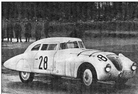
betrug die Durchschnittsgeschwindigkeit eindruckliche 126,3 km/h und dies mit einem kleinen und keineswegs besonders starken Motors, ein eindrucklicher Beweis für die aerodynamische Effizienz des Wagens. Übrigens die normale Straßenlimousine fuhr mit gleichem Motor, 55 PS, ca. 120 km/h Höchstgeschwindigkeit.
